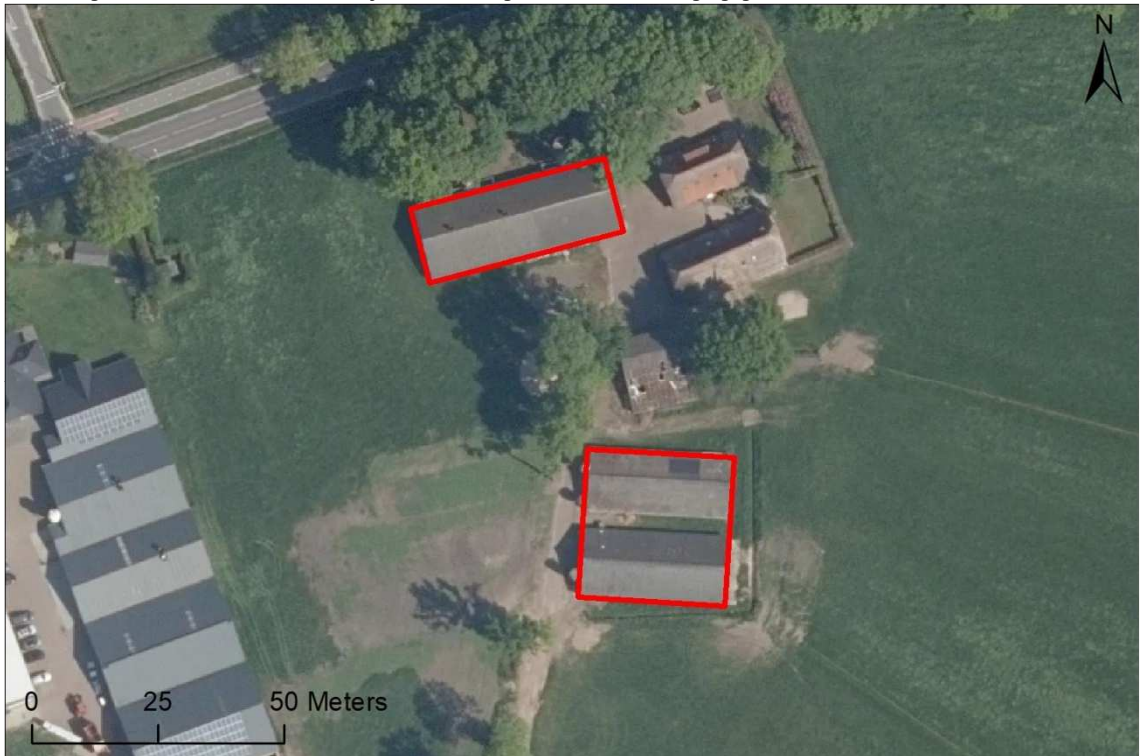
Afbeelding 3.1. Luchtfoto van het bedrijf inclusief de gehanteerde vervangingsgebouwen
